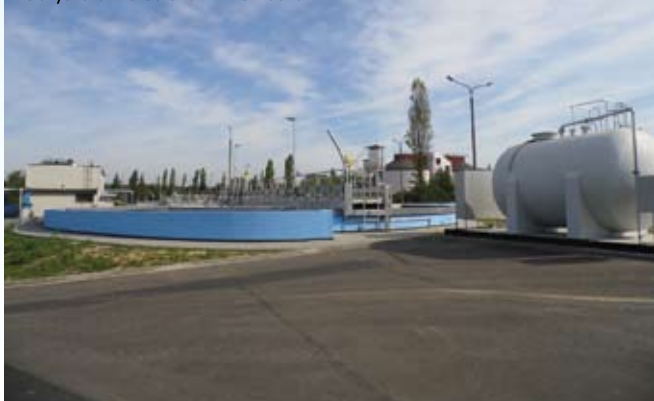
Oczyszczalnia Ścieków w Olkuszu
