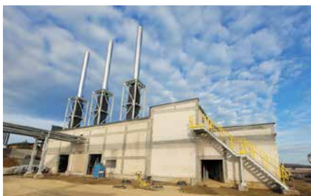
Kogeneracja gazowa w trakcie budowy.
