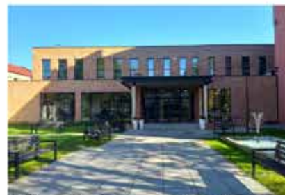
fot.: Nowa sala gimnastyczna przy ZS1 w Olkuszu
